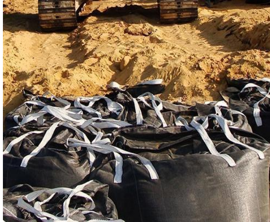
Ilustración 13. Bolsas llenas para conformación de la barrera.
