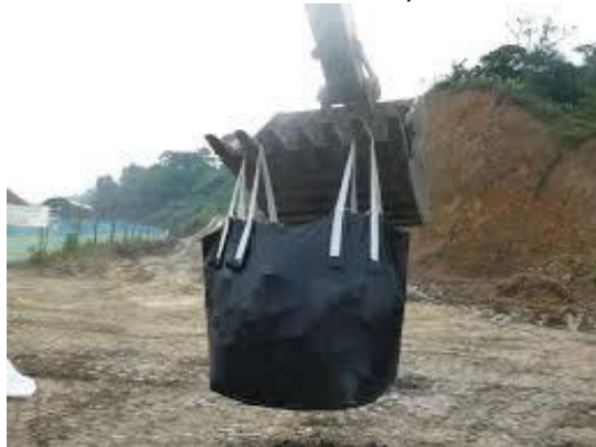
Ilustración 14. Movimiento de las bolsas para conformar la barrera
